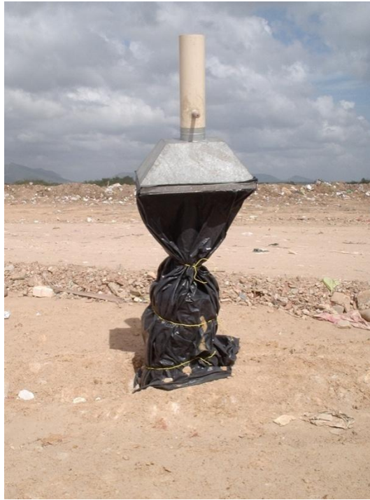
Figura 9: Isolamento do dreno.
