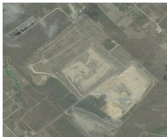
Figura 4 - Vista Aérea do ASMOC. Fonte: Google Earth (2007).
