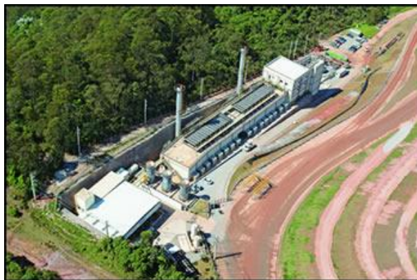
Figura 7: Usina de captação do biogás no aterro São João
