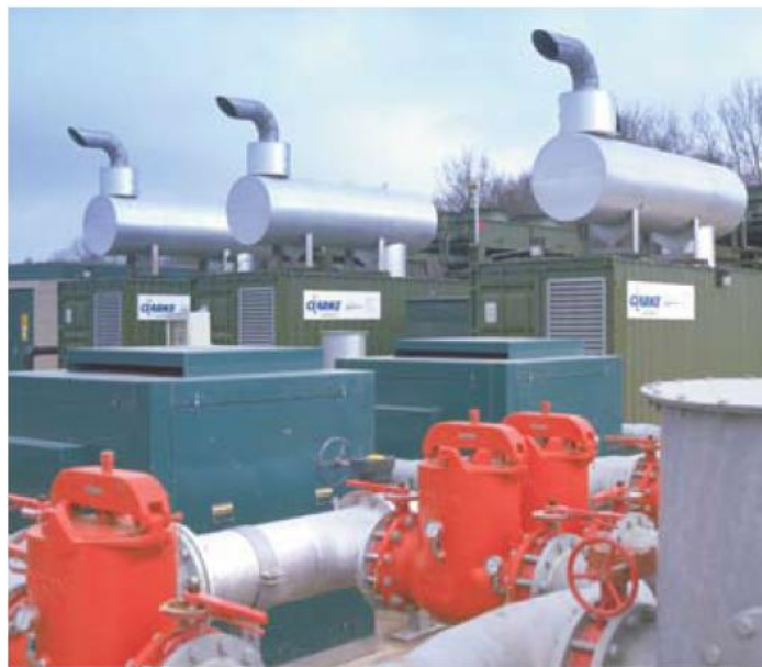
Figura 5: Motogeradores do aterro Bandeirantes (CETREL, 2008).
