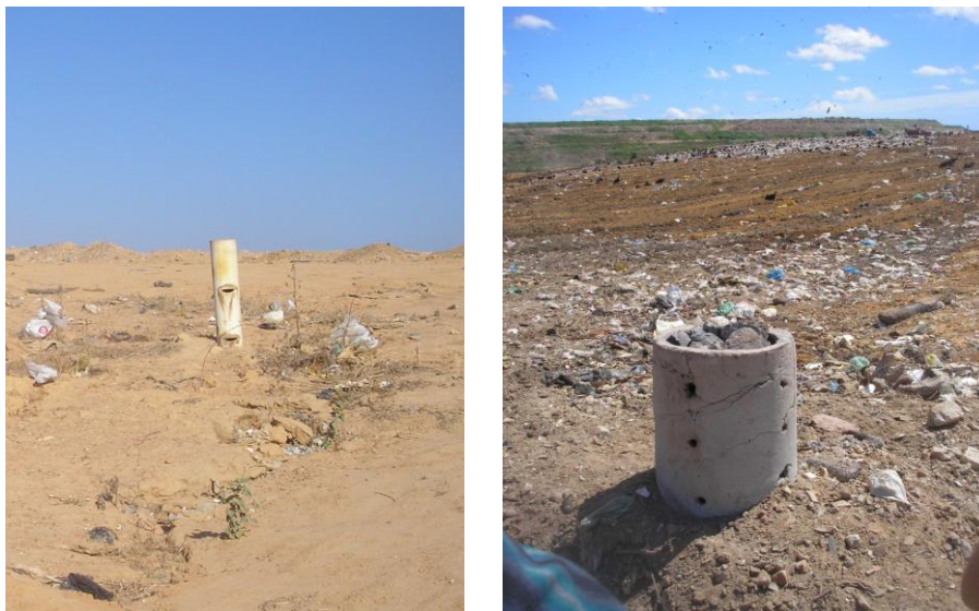
Figuras 14, 15: Dutos de emissão de biogás do ASMOC. À esquerda, em 2007, duto de PVC. À direita, em 2010, duto de concreto.
