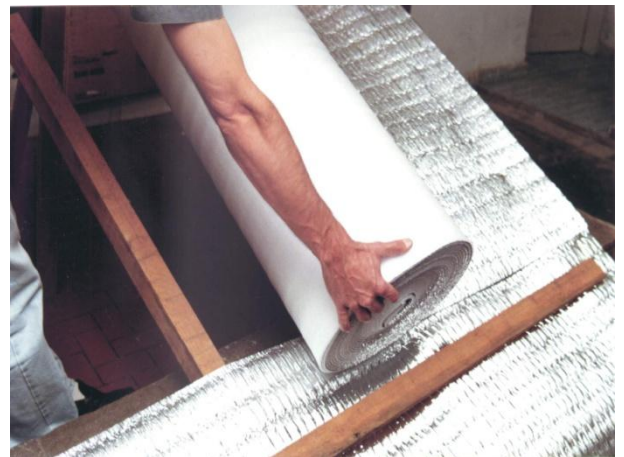
FIGURAS 6 e 7 :Subcobertura aplicada em uma residência (fotos cedidas pela empresa ).
