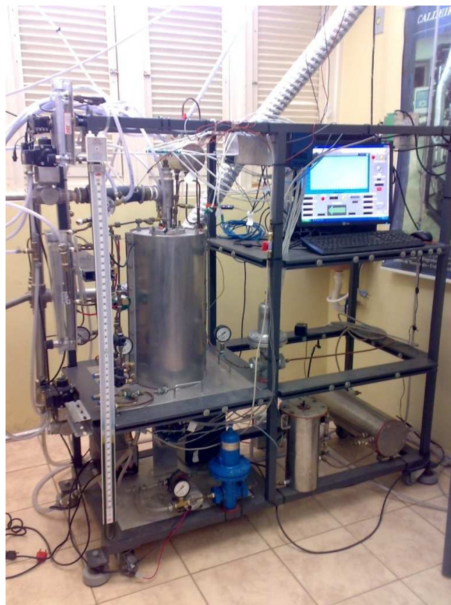
Figura 4.6 - Foto da Caldeira Superadiabática instalada no LACER.
